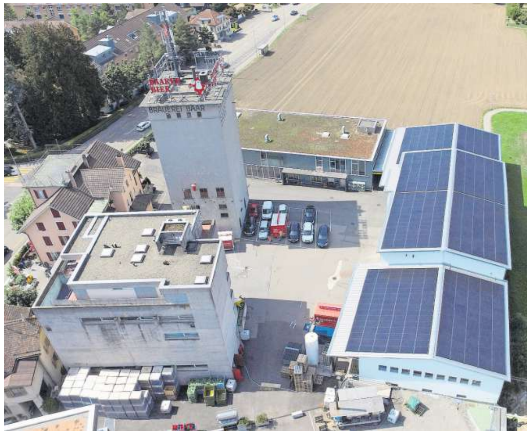
600 sogenannte Fullblack-Module sind neu auf den Dächern der Brauerei an der Langgasse 41 in Baar montiert. Bild: PD
